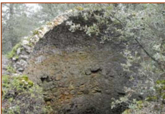
Bóveda del nevero
